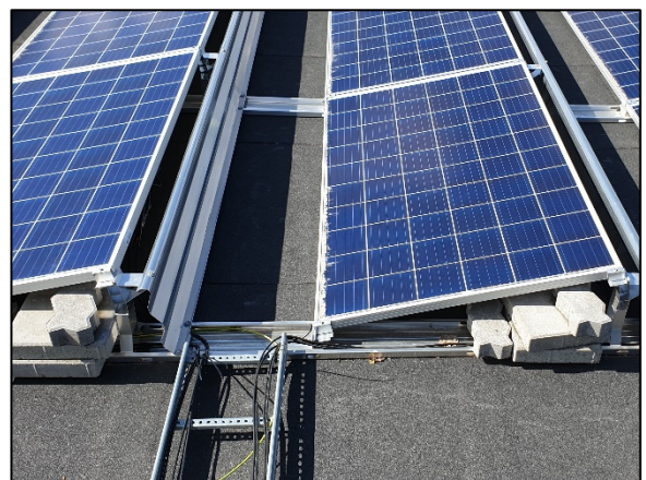
Kuva 8. Aurinkopaneelit lisäpainokiinnityksellä
