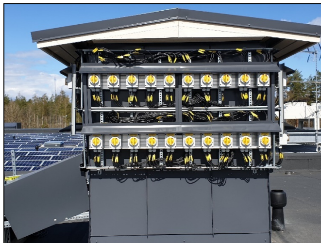
Kuva 10. DC-turvakytkinkeskus katolla
