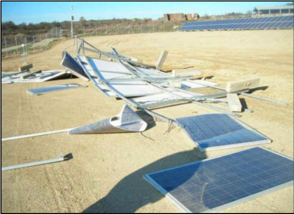
Kuva 5. Aurinkopaneelit myrskytuulen jäljiltä
