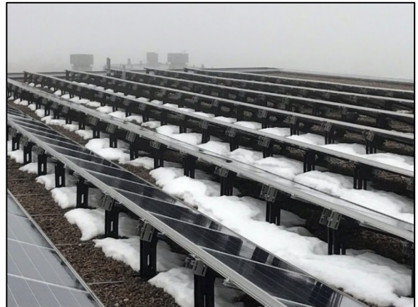
Kuva 7. Aurinkopaneelit vähäisellä lumikuormalla
